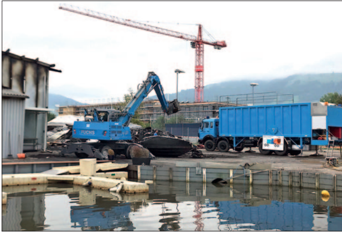
Die Seepolizei Thurgau betreibt den kantonalen Ölwehrstützpunkt und schützt die Binnen- und Fließgewässer
