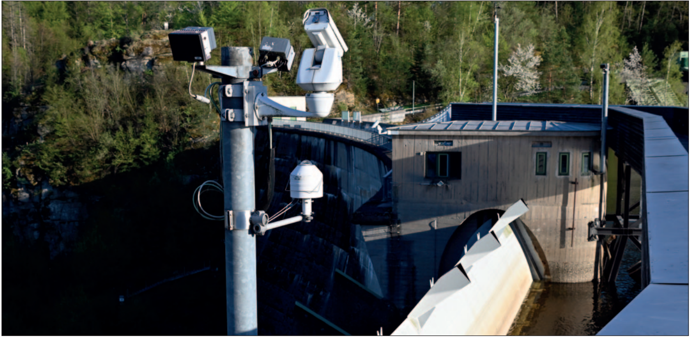
Kraftwerke zählen zur kritischen Infrastruktur und unterliegen besonderen Anforderungen an die Cyber-Sicherheit
