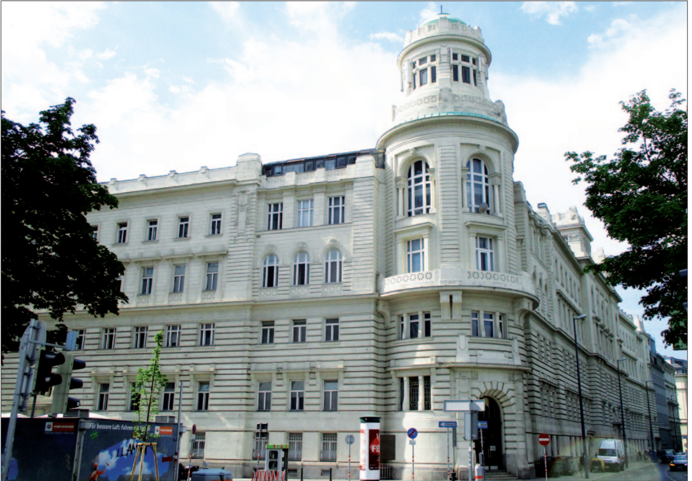
Das 1904 eröffnete Polizeigebäude („Polizeipalast“) an der Rossauer Lände: Sitz des „Kriminalistischen Instituts“
