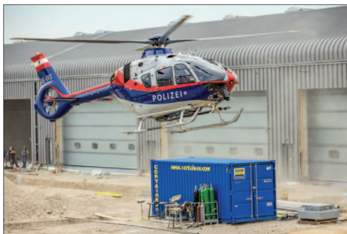
Am Gelände des Einsatzkommandos Cobra in Wiener Neustadt entsteht derzeit eine neue Flugeinsatzstelle.
