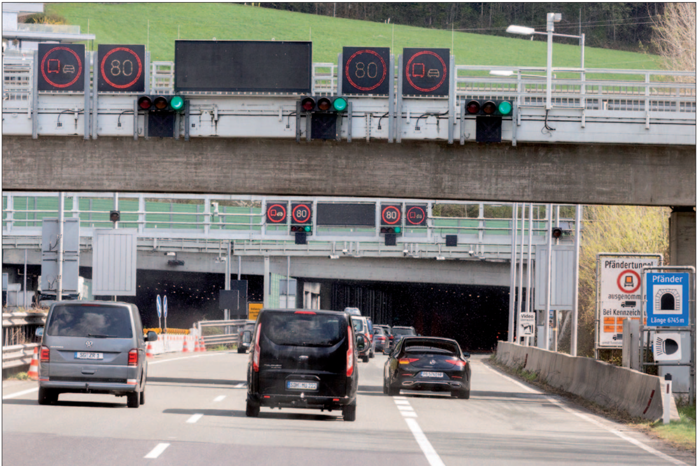
Einfahrt in den Pfändertunnel: Wer sein Kraftfahrzeug in einem Autobahntunnel wendet, verhält sich im Sinne des § 7 FSG (Verkehrszuverlässigkeit) besonders rücksichtslos. Das Wendemanöver erscheint geeignet, besonders gefährliche Verhältnisse herbeizuführen.
