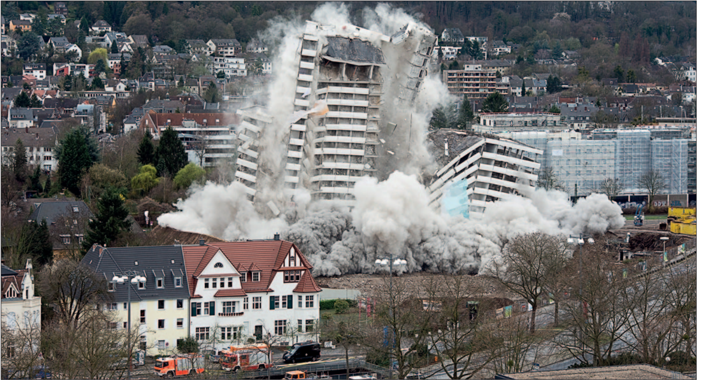
Sprengstoffe können unter anderem bei Abbrucharbeiten eingesetzt werden.
