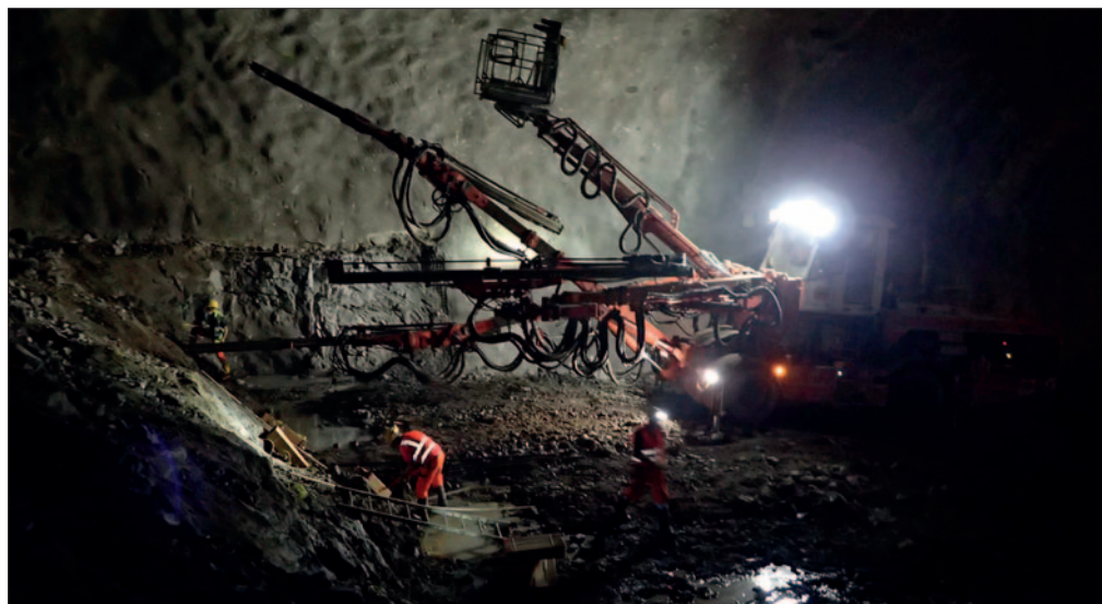
Donauquerung in Linz – Bauabschnitt „Westring“: Vortrieb im Verzweigungsbereich Nord.
