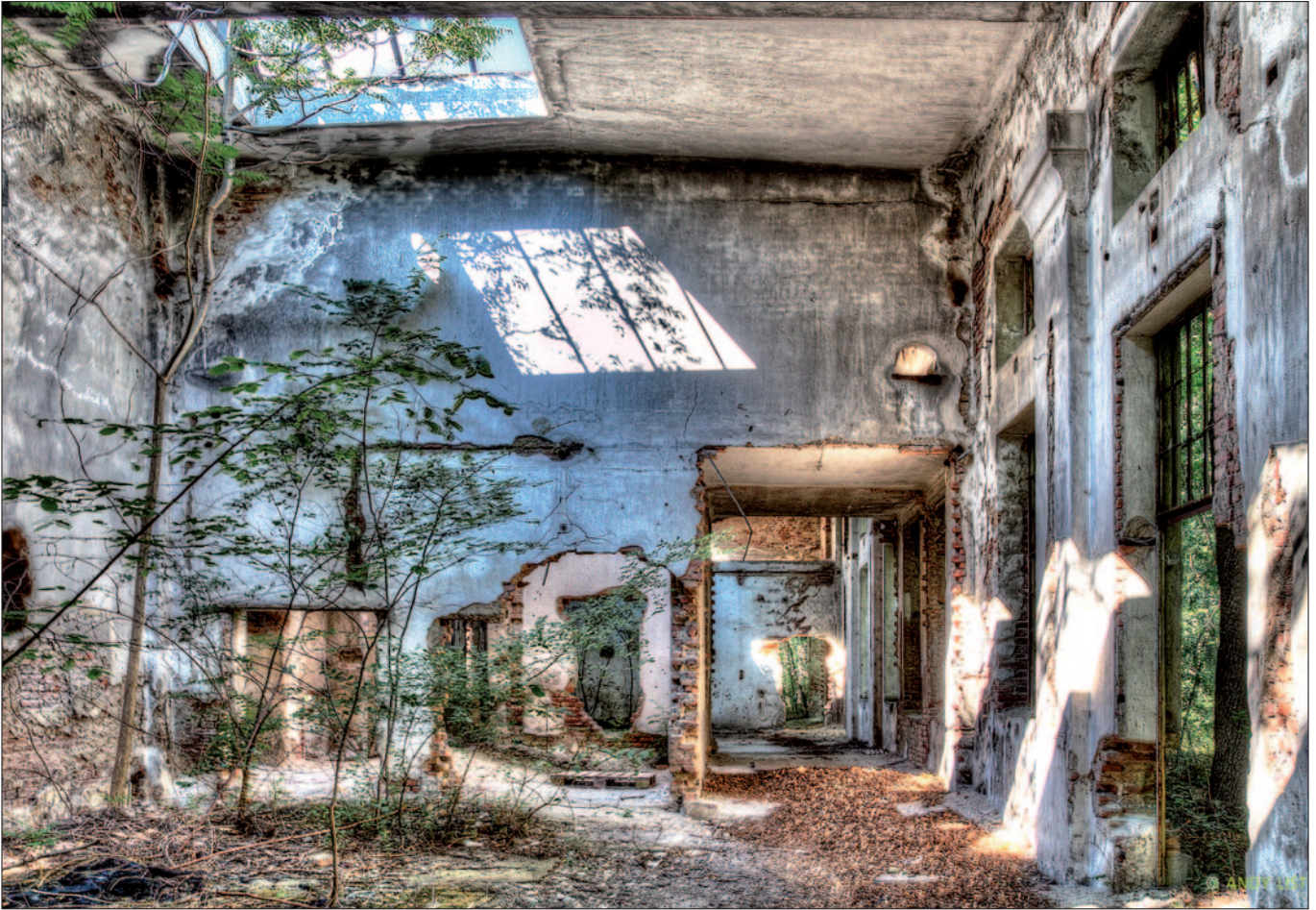
Auf dem Garnisonsübungsplatz in Blumau-Neurißhof befinden sich Gebäuderuinen der ehemaligen Pulverfabrik.
