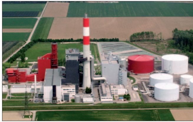
Kraftwerk Theiss im Tullnerfeld: Das europäische Verbundsystem gilt zwar als das größte und stabilste System der Welt, funktioniert allerdings nur als Ganzes.
