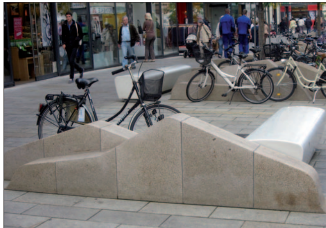
„Street-Furniture“ in Leipzig: Ästhetisch gestaltete Elemente, geeignet als Fahrzeugsperren.
