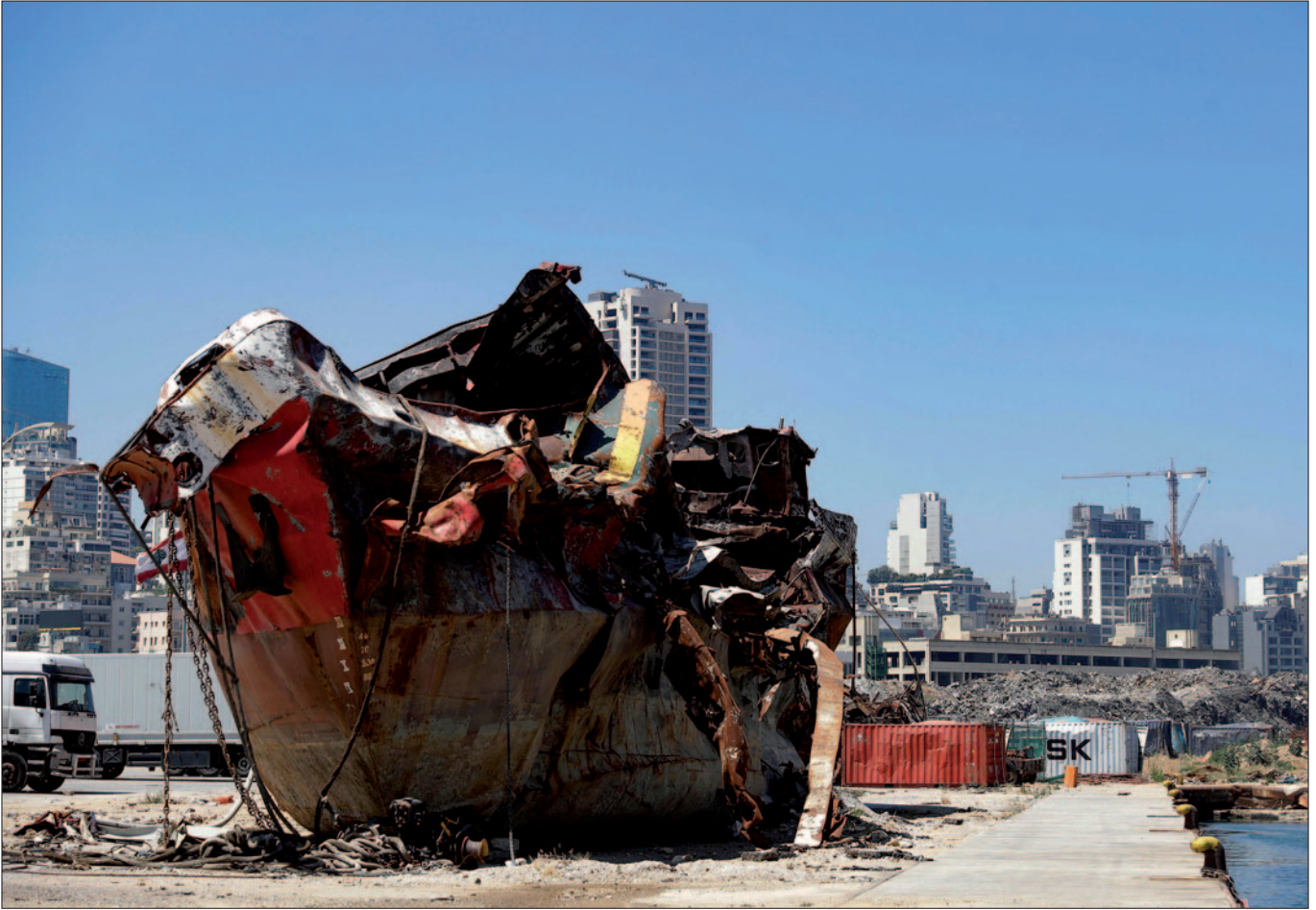
Zerstörtes Schiff im Hafen von Beirut: Ein Jahr nach der Explosionskatastrophe vom 4. August 2020 sind Schäden noch sichtbar.
