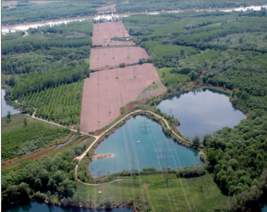
Stromleitungen bei Tulln: In Österreich stehen 12.300 Strommasten. Ein wesentlicher Resilienzfaktor ist ein engmaschiges, ausgebautes Übertragungsnetz.
