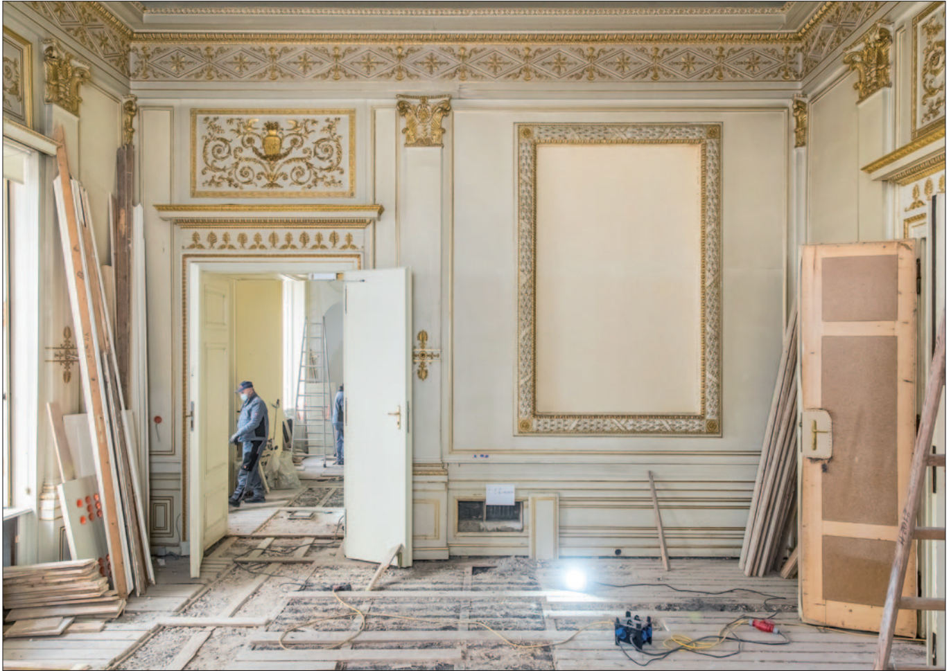
Sanierungsarbeiten in der Beletage des Palais Modena: Erhaltung der historischen Substanz.
