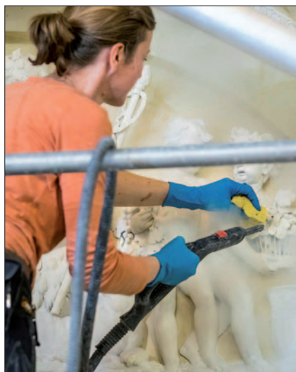
Beletage: Sanierung eines Reliefs.
