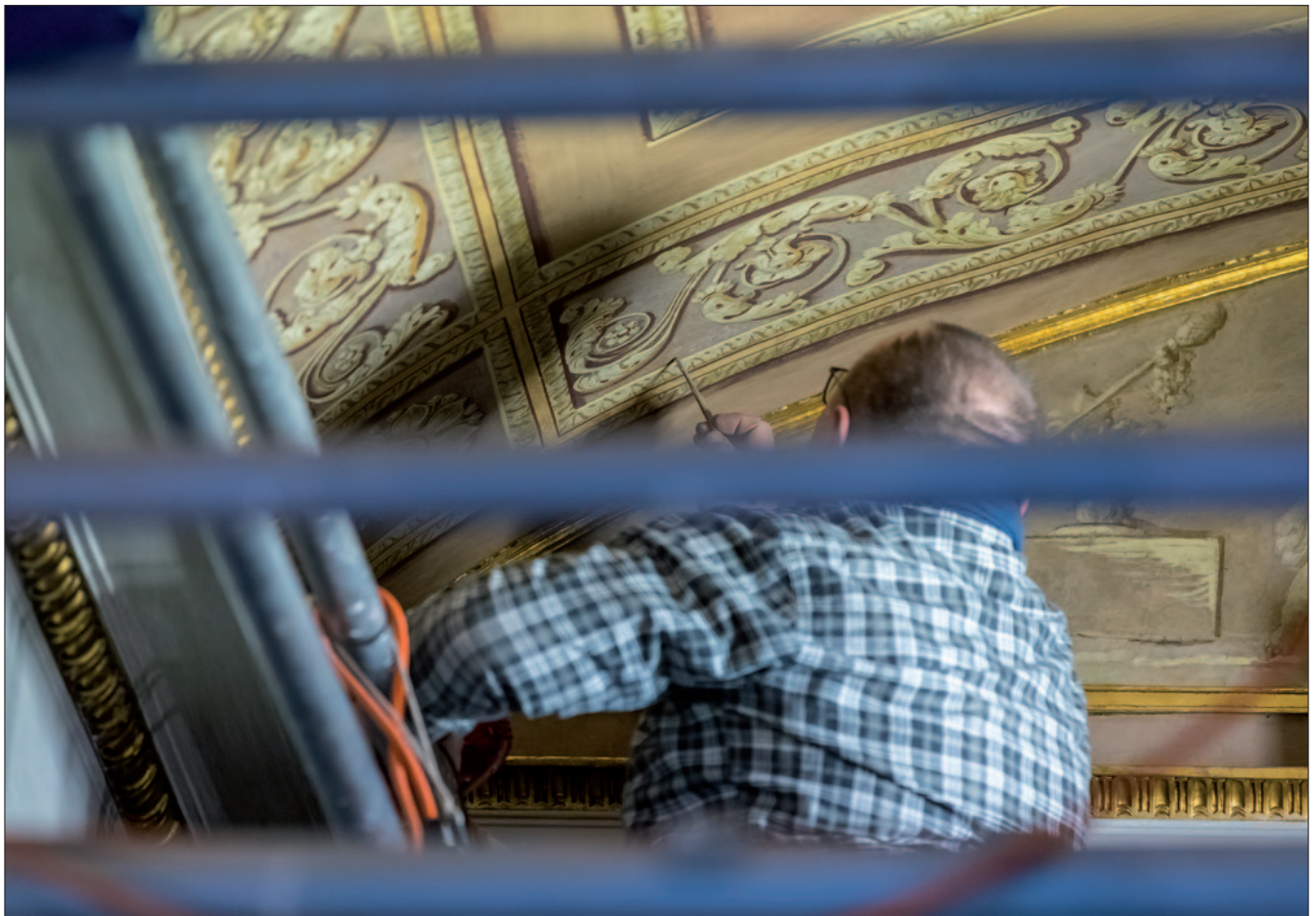
Sanierung der Bausubstanz: Der historische Bestand bleibt erhalten, Haustechnik und Brandschutz werden modernisiert.
