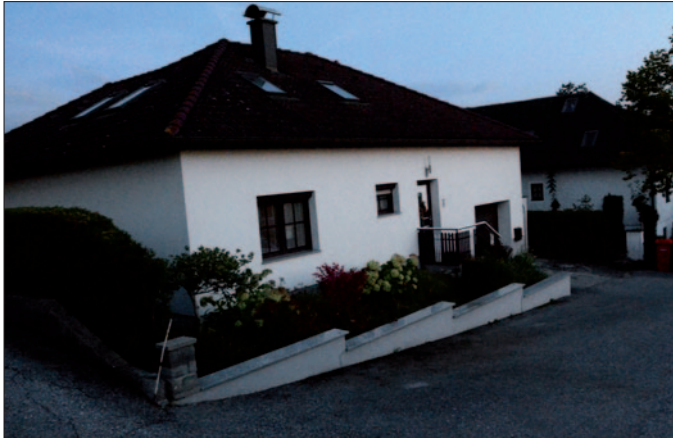
Unbeleuchtete Häuser signalisieren Kriminellen, dass niemand zuhause ist; Zeitschaltuhren für die Beleuchtung verwenden.
