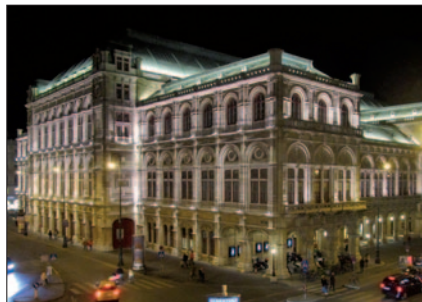
Staatsoper: Egon Hilbert engagierte sich für den Wiederaufbau des 1945 schwer beschädigten Operngebäudes.
