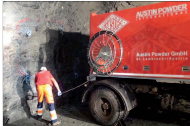
Mischladegerät: Einbringung des Sprengstoffes in Bohrlöcher.
