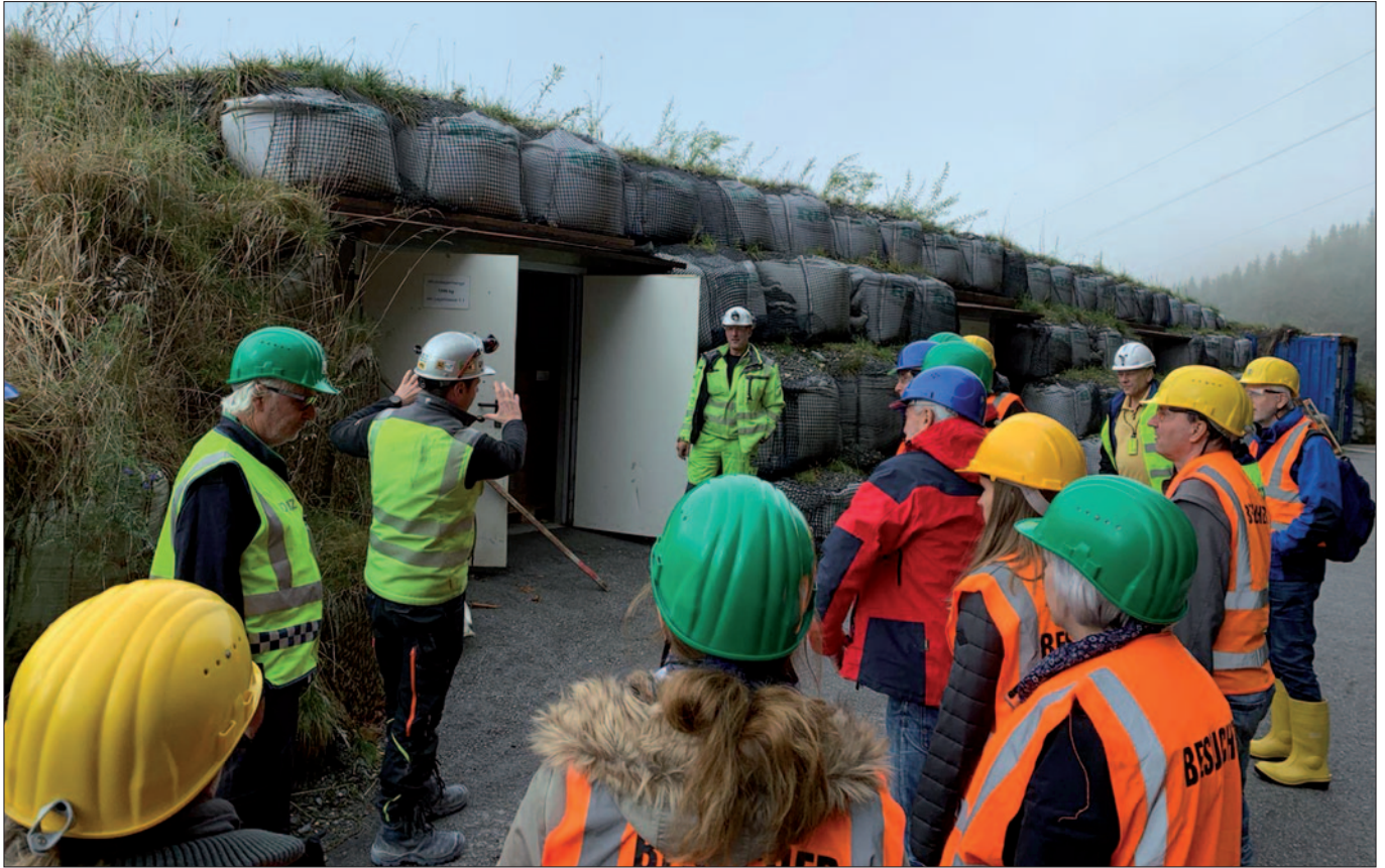
Sprengmittellager der Baustelle des Semmering-Basistunnels: Lager müssen von der Landespolizeidirektion genehmigt sein.
