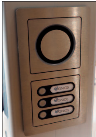
Türkommunikationssystem: Klingel ist mit Smartphone des Bewohners verbunden.
