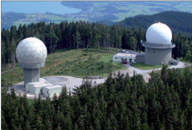
„Goldhaube“: Das Luftraumbeobachtungs- und Führungssystem des Bundesheers befindet sich auf der Koralpe.
