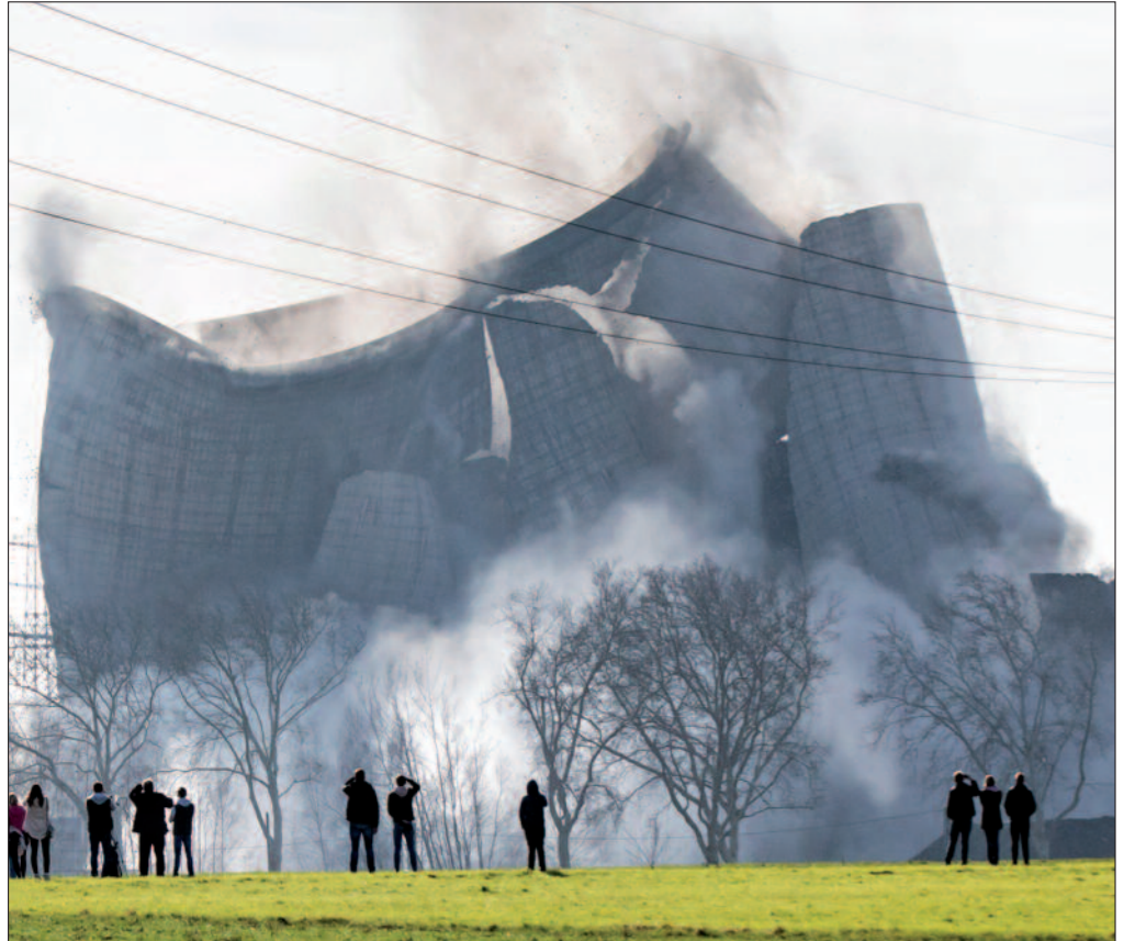
Beispiel einer erfolgreichen Sprengung am 17. Februar 2019 in Castrop-Rauxel, Nordrhein-Westfalen: Der Kühlturm eines ehemaligen Kraftwerks fällt nach einer Sprengung zusammen.
