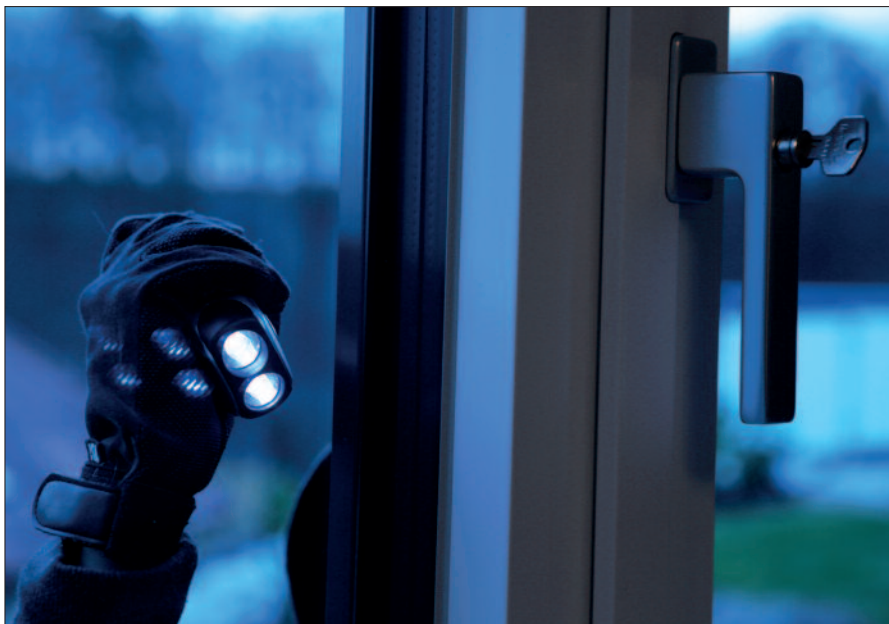
Schwachstelle Fenster: Die meisten Einbrecher sind Gelegenheitstäter.
