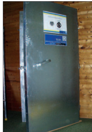
Schutzraumtüre: Stahlblechtürblatt verzinkt.
