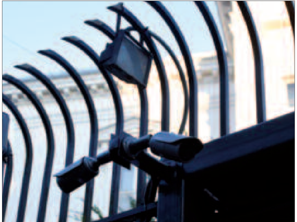
Sicherheitszaun mit Videoüberwachung: Der Gebäudeschutz beginnt an der Grundstücksgrenze.
