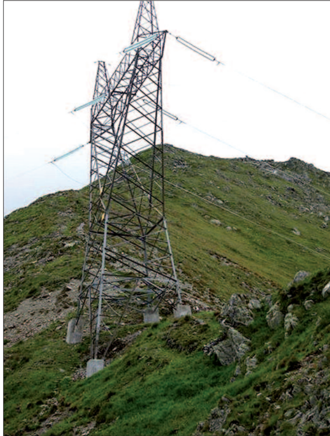
Porzescharte in Südtirol: Vier Todesopfer bei einem Sprengstoffanschlag auf einen Strommasten vor 50 Jahren.
