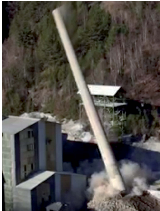
Sprengung eines Schornsteins der RHI Radenthein: Der Schornstein musste in eine Lücke zwischen zwei wichtigen Betriebsanlagen fallen.
