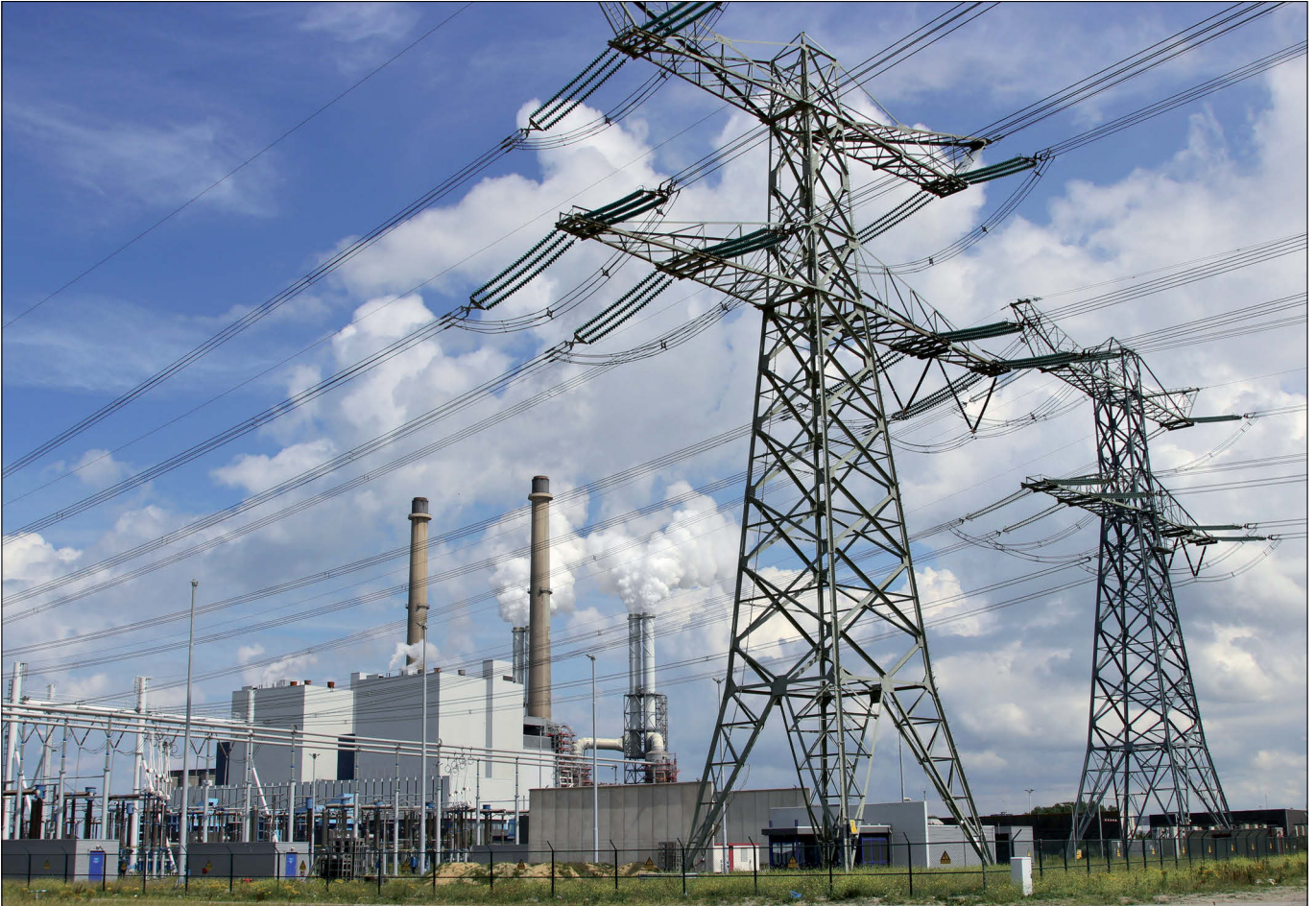
Stromerzeugungsanlagen zählen zur kritischen Infrastruktur eines Landes und können Ziele von Sabotage werden.
