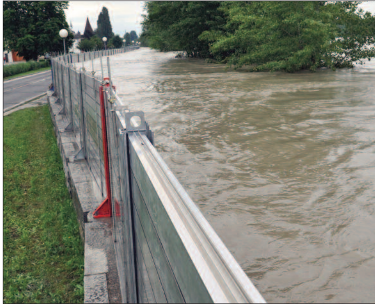
Mobiler Hochwasserschutz in Stein an der Donau beim Hochwasser im Juni 2013: Fortschritte im Hochwasser-Risikomanagement.
