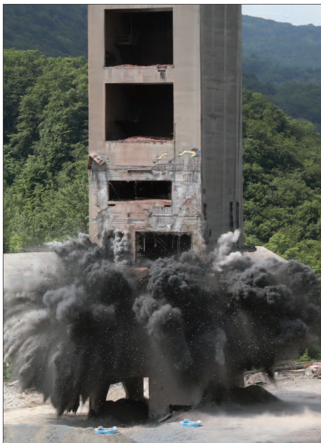
Sprengung eines Stahlbetonturms des ehemaligen Zementwerks Kaltenleutgeben durch das Bundesheer.
