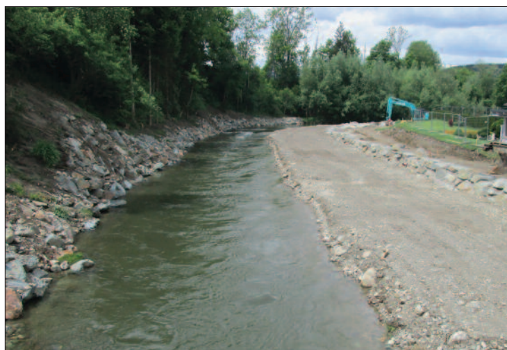
Hochwasserschutzbau: Dem Jahrhunderthochwasser vorbeugen.
