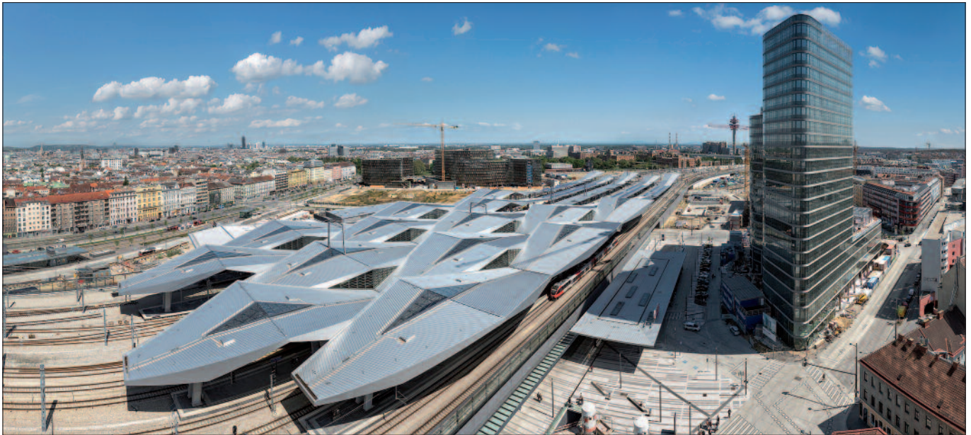
Hauptbahnhof Wien: 109 Hektar Bahnhofsareal und Geschäftsviertel mit etwa 115 Geschäften und Gastronomiebetrieben.
