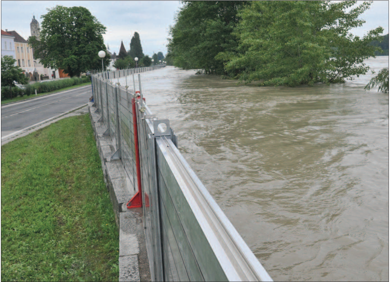
Mobiler Hochwasserschutz in Krems/Stein während des Hochwassers im Juni 2013: Das Innenministerium hat 2013 einen staatlichen Risikoanalyseprozess für Naturkatastrophen und von Menschen verursachten Katastrophen eingerichtet.
