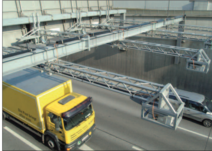
Section-Control-Anlage im Kaisermühltunnel in Wien.
