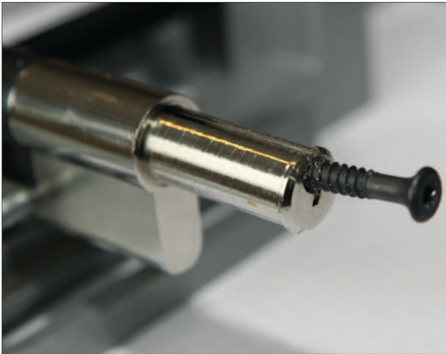
Kernziehen: Der häufigste Fehler ist ein vorstehender Schließzylinder.
