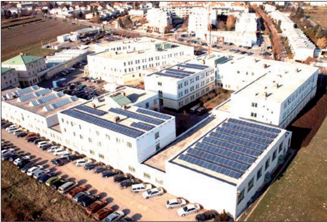
Fotovoltaik-Anlagen im Landespolizeikommando Burgenland und beim Einsatzkommando Cobra: Die beiden Anlagen liefern 100.000 bis 120.000 Kilowattstunden Strom pro Jahr.
