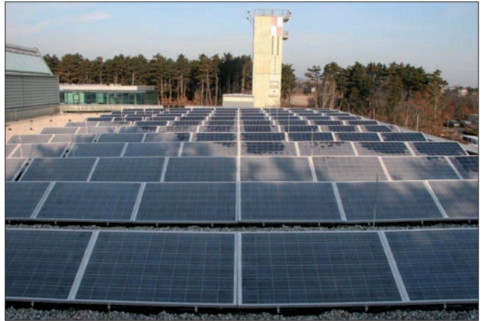
Fotovoltaik-Anlagen im Landespolizeikommando Burgenland und beim Einsatzkommando Cobra: Die beiden Anlagen liefern 100.000 bis 120.000 Kilowattstunden Strom pro Jahr.
