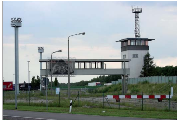
Kontrollturm, Rundumleuchten: Der Kernbereich der DDR-Grenzübergangsstelle Marienborn ist unter Denkmalschutz.
