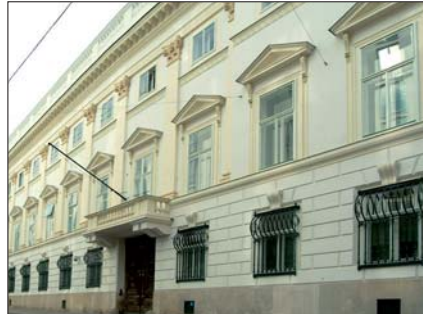
Zentralstelle des Bundesministeriums für Inneres: Neue Geschäftseinteilung.
