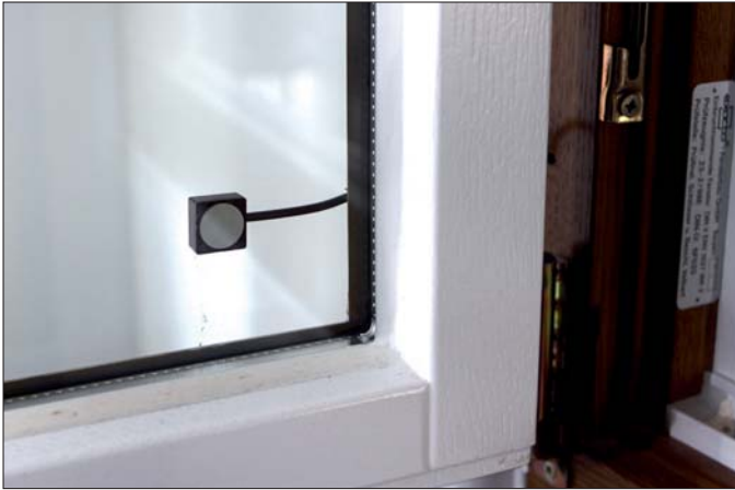
Glasbruchmeldeanlage: Laut einer Studie dringen 72 Prozent der Täter bei Häusern durch ein Erdgeschosfenster ein.
