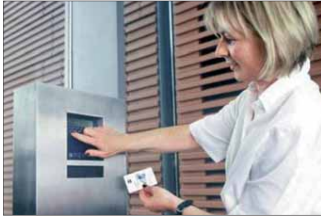
Zur Zutrittsregelung können Ausweise sowie biometrische Merkmale herangezogen werden.
