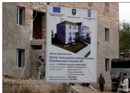
Bau des Trainingszentrums der Grenzschutzbeamten in Bischkek, Kirgisistan; finanziert von der Europäischen Union.
