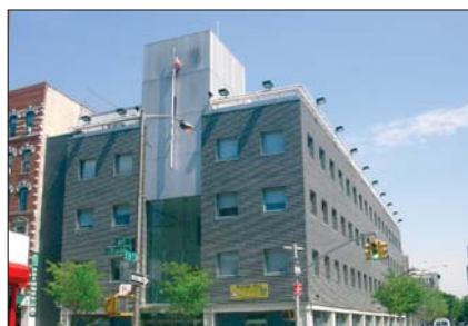
Ausweichquartier des 9. Polizeireviers während des Umbaus.
