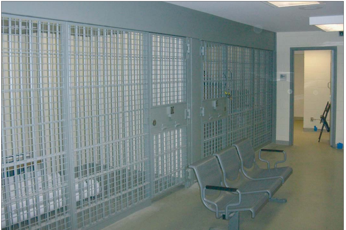
Modernisierter Zellentrakt des berühmten 9. Reviers: Türen und Gitter aus rostfreiem Stahl.
