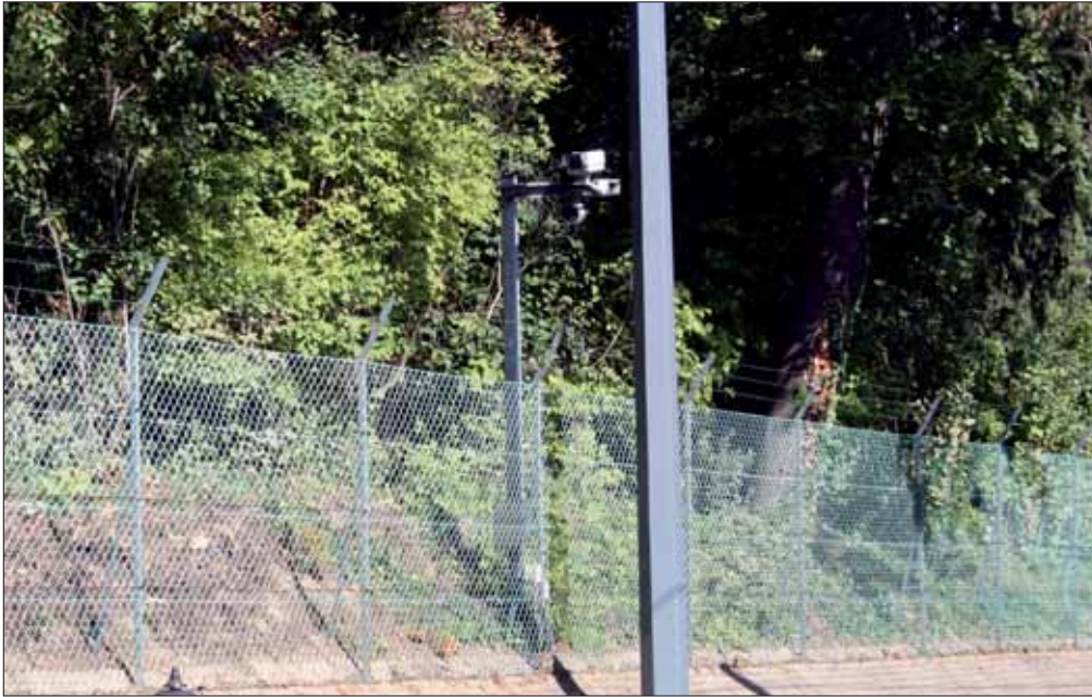
Hochsicherheitszaun: Objektsicherheit beginnt an der Grundstücksgrenze.
