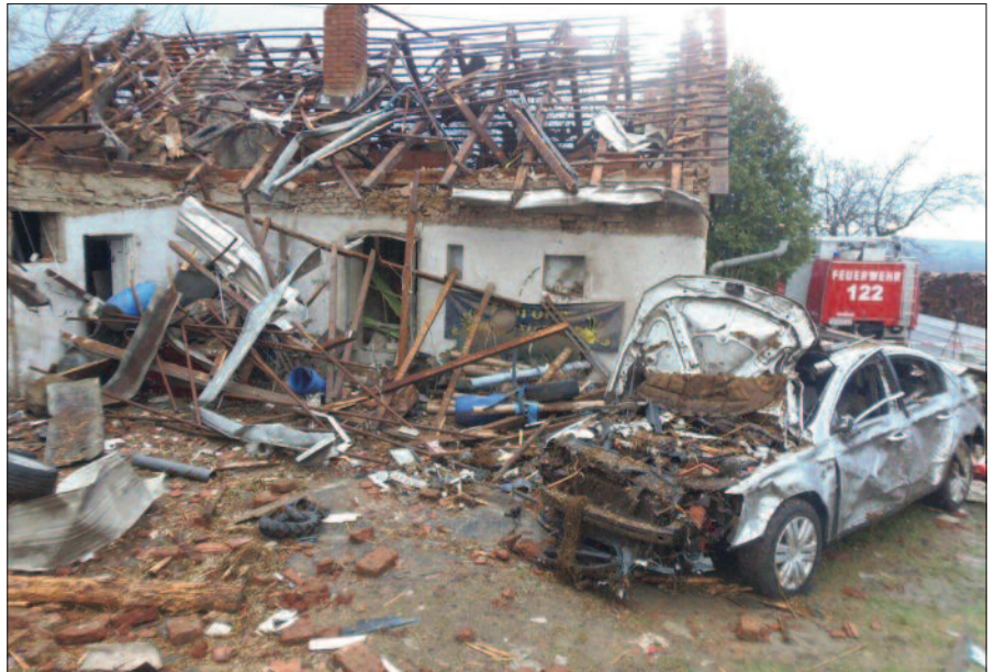
Schäden nach der Explosion eines Pyrotechniklagers in der Steiermark.
