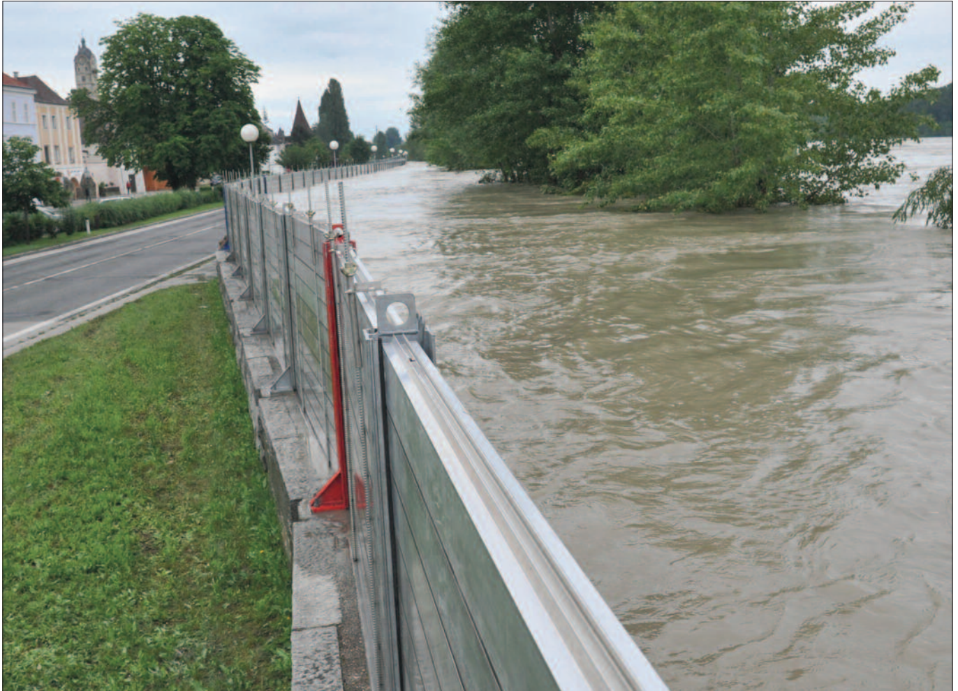
Mobiler Hochwasserschutz in Krems/Stein während des Hochwassers im Juni 2013: Das Innenministerium hat 2013 einen staatlichen Risikoanalyseprozess für Naturkatastrophen und von Menschen verursachten Katastrophen eingerichtet.
