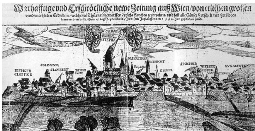
Abb. 7. Schäden in Wien anlässlich des Erdbebens von 1590 bei Ried am Riederberg.
