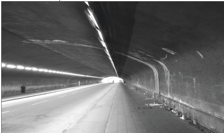
Abb. 7: Zu- und Abgangsweg und Fluchtweg zum Veranstaltungsgelände durch den Tunnel Karl-Lehr-Straße
