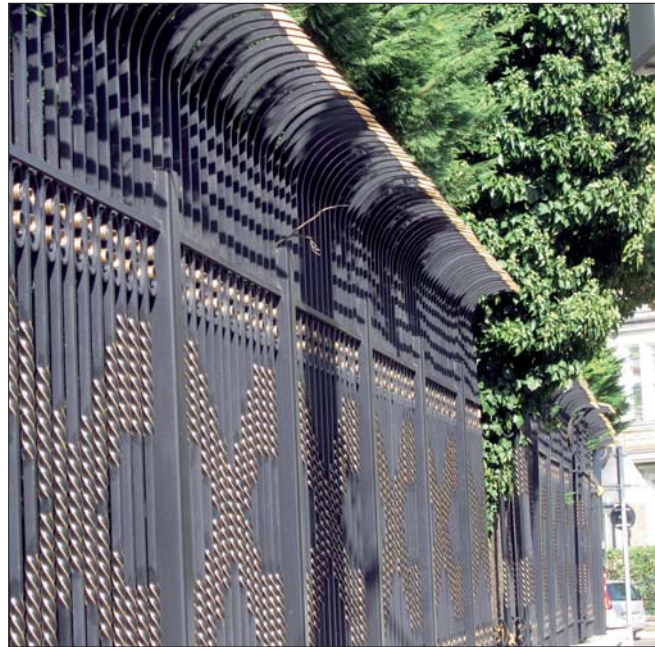
Metallschutzzaun mit nach außen gewölbtem Zacken: Perimeterschutz ist ein wichtiger Teil der Objektsicherheit.
