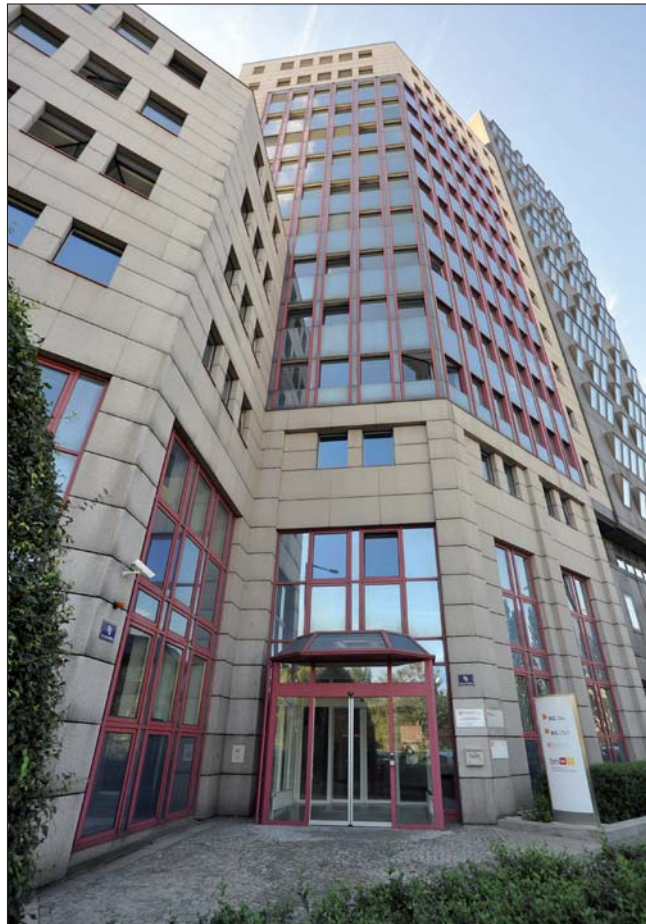
Sitz der zentralen Staatsanwaltschaft zur Verfolgung von Wirtschaftsstrafsachen und Korruption in Wien-Erdberg.
