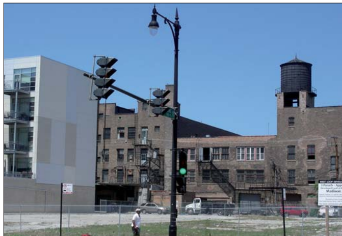
Stadterneuerung: Moderne Wohnprojekte neben baufälligen Substandardgebäuden verschieben auch die Gang-Reviere.
