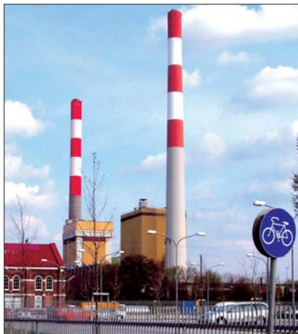
Kraftwerke: Kritische Infrastruktur.
