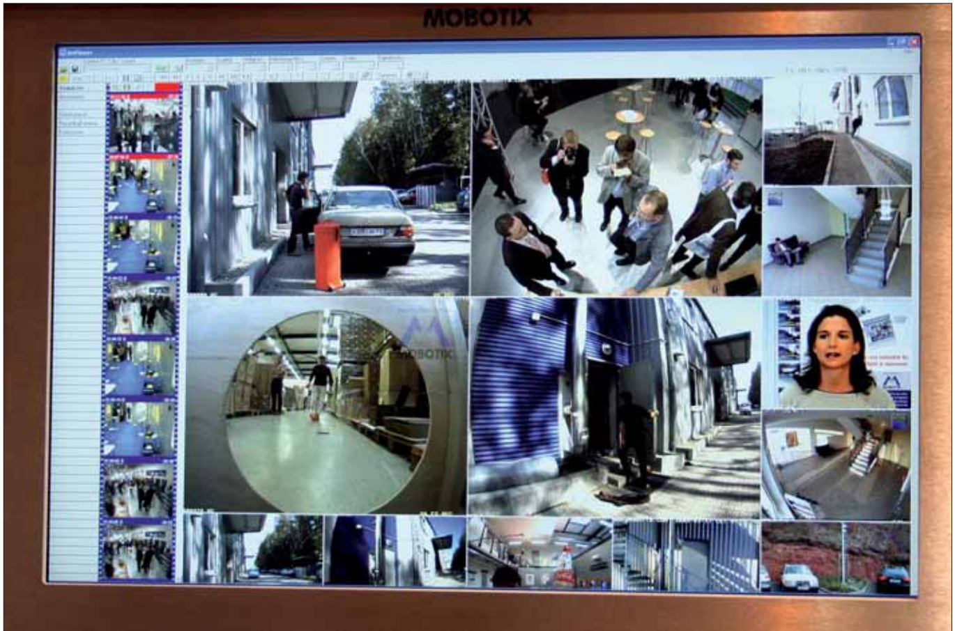
Videüberwachungssystem (präsentiert auf der Security 2006): Sicherheitsmaßnahmen müssen von Insidern und Externen als zumutbar und notwendig empfunden werden.
