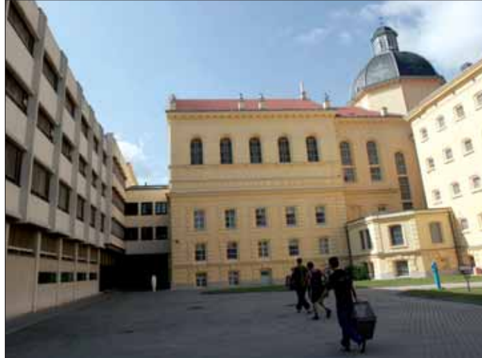
Viele Justizanstalten sind in älteren Gebäuden untergebracht und müssen an die Sicherheitsverhältnisse angepasst werden.
