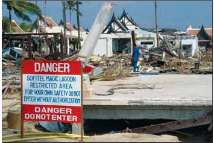
Zerstörtes Hotel „Sofitel“ in Thailand.
